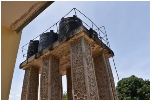
Abastecimiento de agua para la Clínica Kipalapala - Tabora
